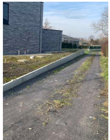
Het Gravenwegeltje vormt de verbinding tussen de Diksmuidesteenweg en de Duivelsbeek. Deze trage weg zal worden omgevormd tot een vlonderpad.
